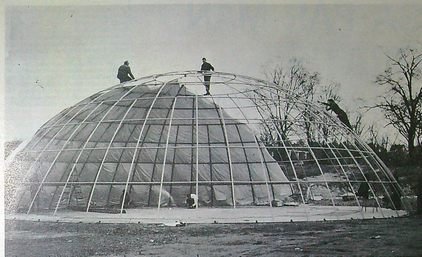
Ett exempel på hur hela hus kan uppföras med byggsystem. Här en kupolhall byggd med Abstracta System. Beklädnaden är ett material från Mab och Mya benämmt Maborex, en mycket stark plastväv.
