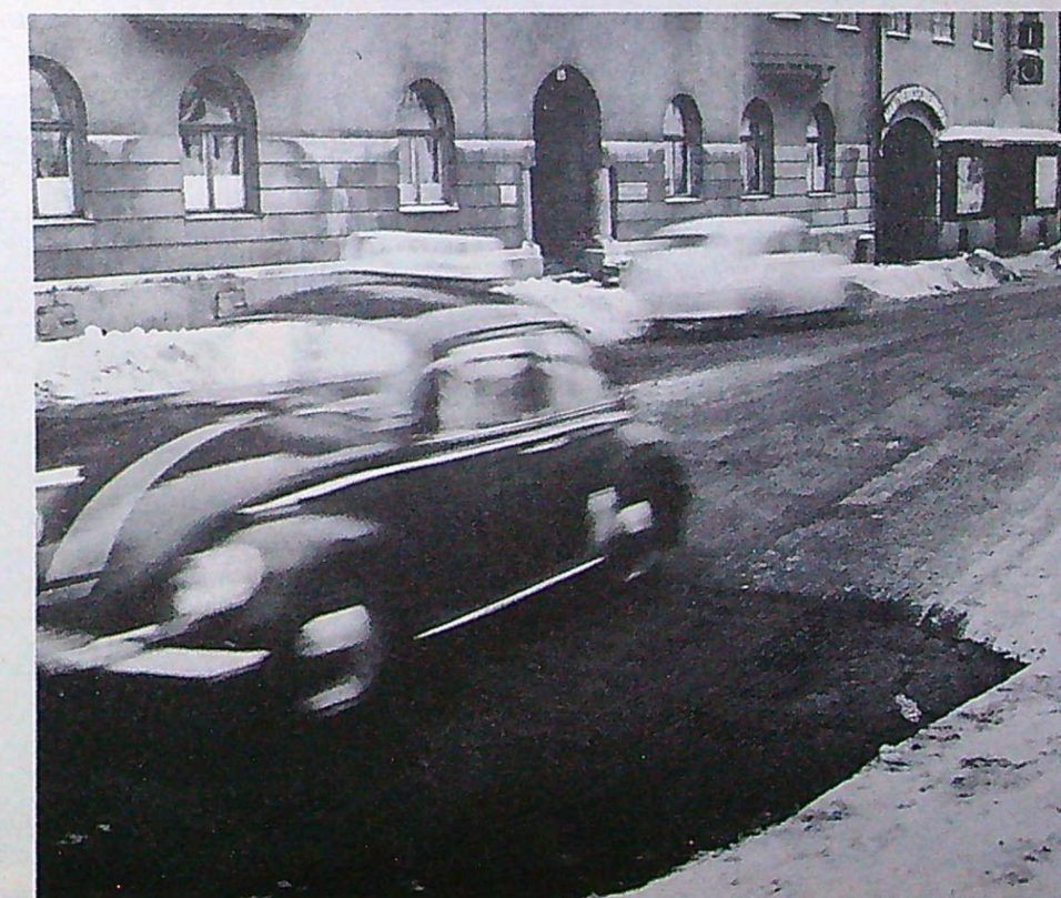
Skillnaden mellan uppvärmd och vanlig gatubeläggning är märkligt. På den uppvärmda sektorn är det nästan helt torrt medan den vanliga gatan täcks av ett decimetertjockt islager.
