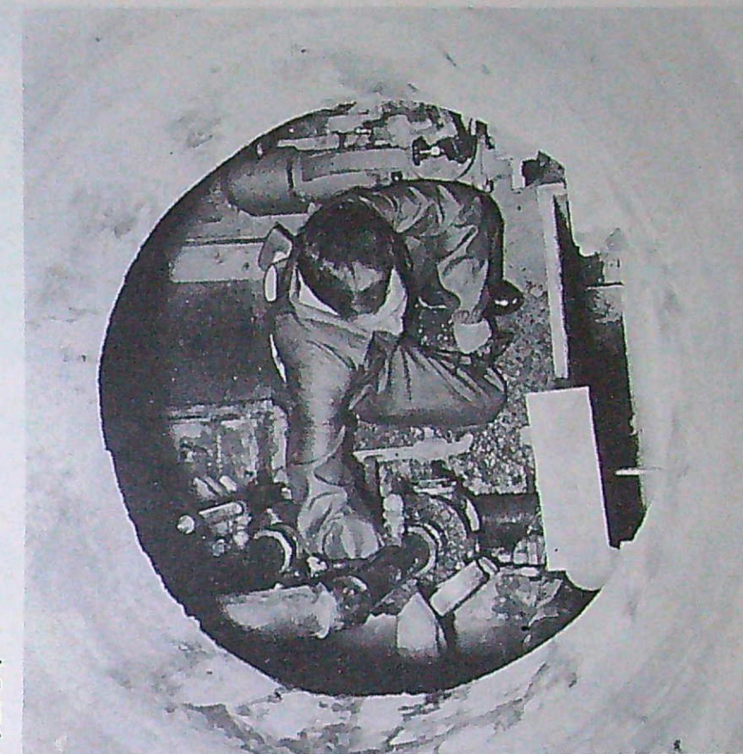
Större än så här är inte värmecentralen till Carolinabacken. Den ligger nedsänkt i en ordinarie brunn alldeles intill körbanan.
