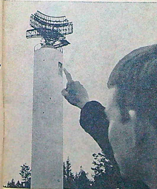
På bilden översiktsradars antenn. Den sköts liksom den övriga tekniska utrustningen av Televerkets Radio Maintenance Service (RMS). RMS har också hand om tekniska tjänsten på Bromma.
