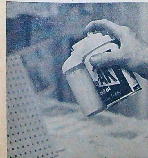
På bilden sprutas en perforerad skiva. Penselmålning hade här troligen gett sämre resultat.
