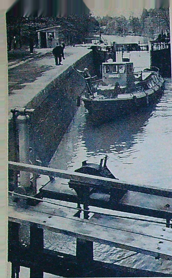
I Hajstorp experimenterar man med en hydrauliskt manövrerad sluss. Slussvakten öppnar och stänger luckor och slussportar centralt från en manöverhytt invid slussen.
