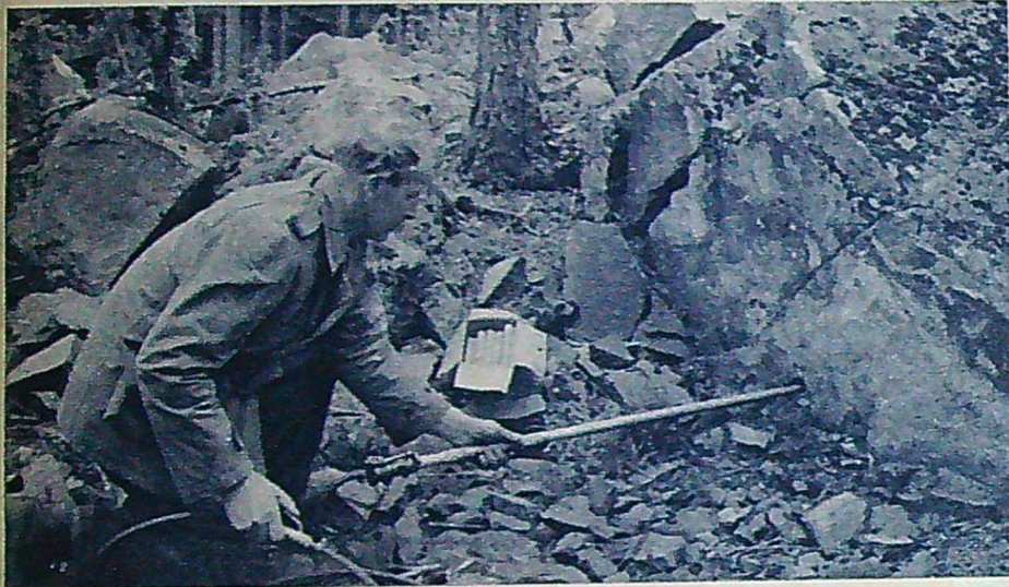
Sprängarens arbete blir mer och mer mekaniserat. Tryckluftsdrivna borrar äter sig ned genom berget. Och numera drivs även laddapparaterna av tryckluft.
