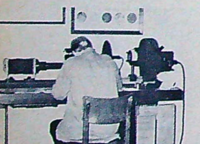
Ett spektroskop är ett av metallurgens viktigaste redskap. Med detta gör man direkta materialanalyser.
