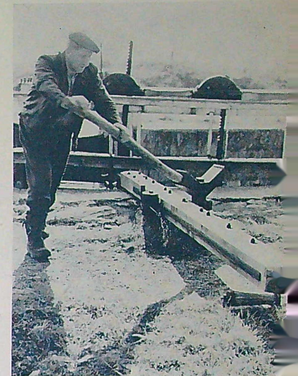
Slussarna vid Strömsholms kanal byggdes för över 100 år sedan. Väggarna är av huggen granit och portarna är rejäla don med balkar, som mäter upp till 18 tum i fyrkant. Bilden nedan visar ett av handspelen, av vilka det finns fyra vid varje sluss.
