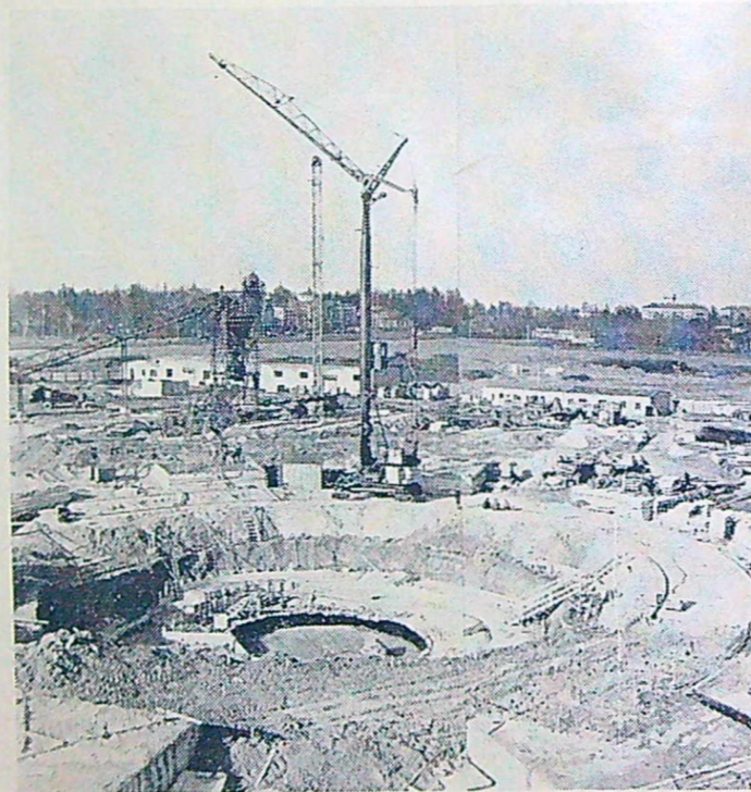
Arbetet med gjutningen av det väldiga betongfundamentet för världens högsta byggnadsverk, Moskvas TV-torn, har börjat. Grunden blir 62 m bred.
