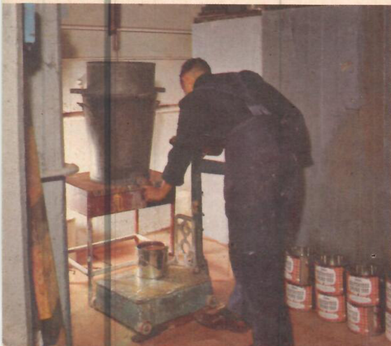
På bilden ovan har färgpigmentet gått vidare till blandningsavdelningen, där den blandas i en s.k. planetblandare. Bilden under visar tappning av färg i burkar ur en av kulkvarnarna. I denna bearbetas bindemedel och pigment av porslinskulor varvid blandning och rivning sker samtidigt.
