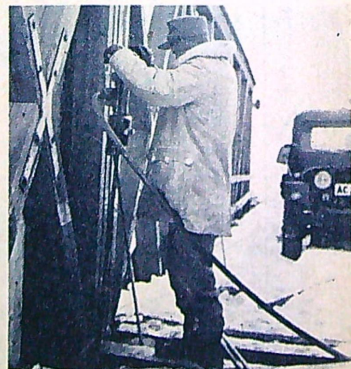
Den gamla hängbron t. v. hade tjänat ut och måste bort. En ny, bred bro har byggts alldeles intill. Ovan har man kört fram en tryckluftsjep och borrar för sprängning av betongfästena.
