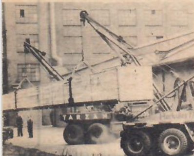
Tack, jag tar lådan! Och det är inget att förlora på det valet. Jättelådan på bilden t. v. innehåller nämligen den 18 m långa vävstol, som syns på bilden t. h. Vävstolen används för att göra maskinfilt till cellulosafabriker och Astra-Werke utanför Hamburg tillverkar giganten.
