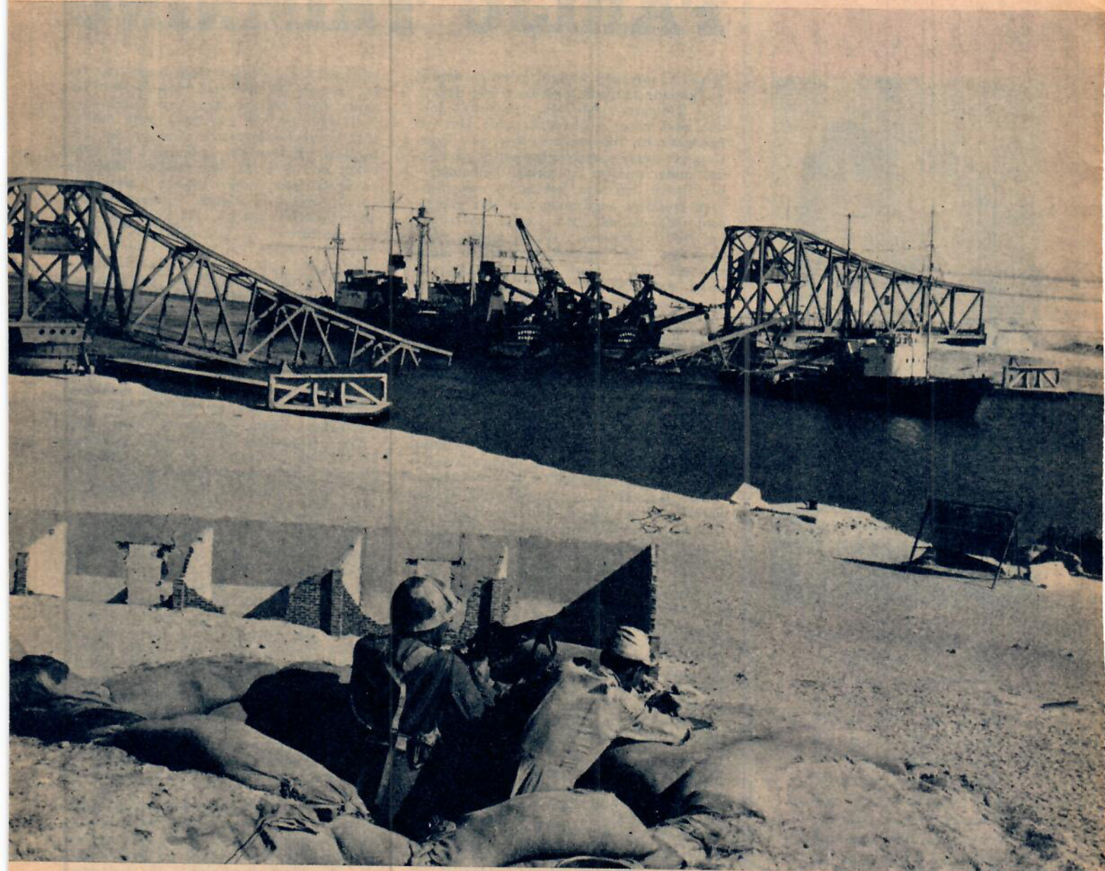
Den sönderprägnada bron vid El Ferdan norr om Ismailia gav bärgningsexperterna huvudbry. Röjningsarbetet bevakas ständigt av hotfulla egyptiska gevärsmynningar.
