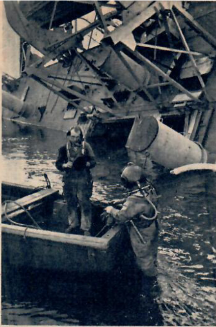
Röjningsflottans dykare ligger i dygnet runt med förundersökningar, rätning av läckor o. d. Hårt arbetsprogram som kräver vältränat folk.
