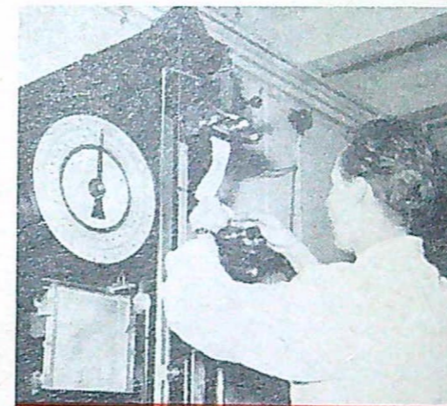
Ovan: Ingenjör G. Lindgren sätter in en tygremsa i schopperapparaten för bestämning av avslitningskraften.
