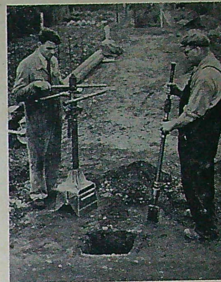
En på Mässan demonstrerad brittisk hårlämningsmaskin, som på 10 minuter tar upp ett 1 m djupt fyrkanthål på 30x30 cm.
