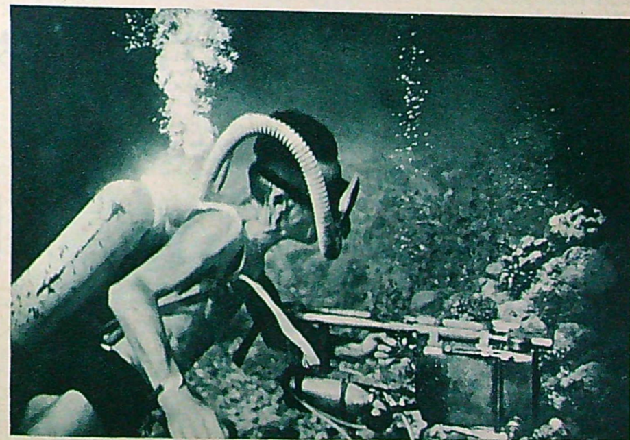
Här färgfotograferar kapten Cousteau på Medelhavets botten. Rolleiflexkameran är innesluten i en vattentät tryckluftbehållare som avpassats så att kameran är helt viktlös under vattnet. Inställning, filmframmatning och exponering sker med lättillgängliga manöverorgan.
