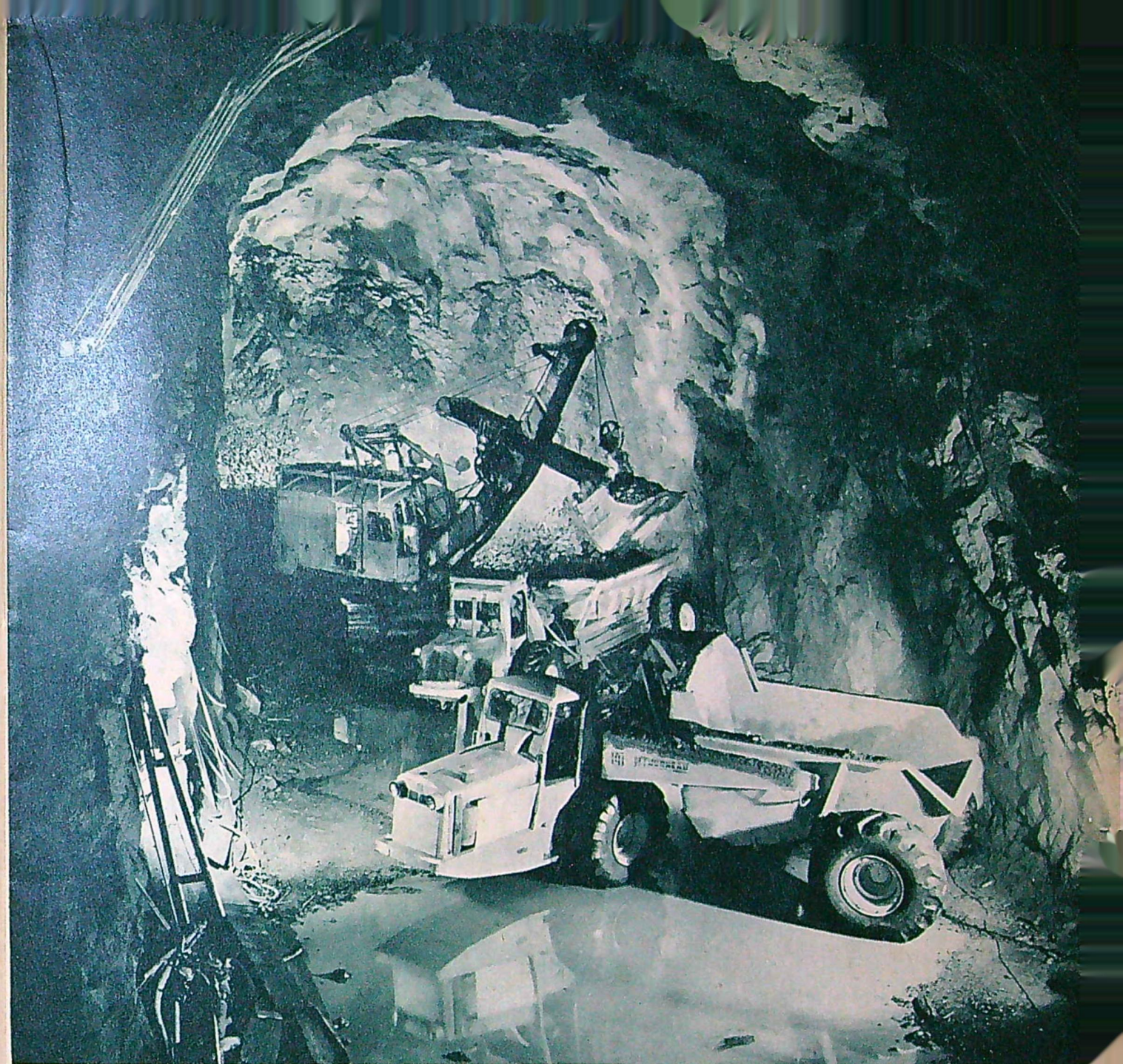
Kraftverksbyggnarna i Dönje är snart klara med en fem kilometer lång bergtunnel värdig Bergakungen själv. Efter varje sprängsalva skryftar grävskopor sprängstenen på jättelika truckar som
