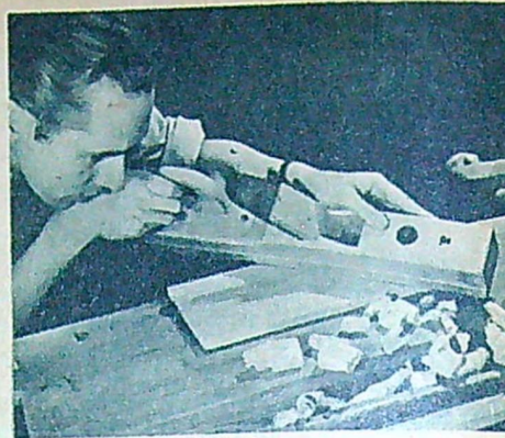
Med hjälp av hyvelns kant kontrollerar vi om vi fått det bearbetade materialets sidor raka.
