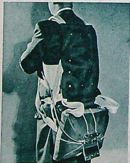
Ingenjör Ture Nilsson med sittskärm och sele av centrallästyp. T. v. ses den långa vajern som går från utlösningshandtaget till springarna, som fasthåller skärmen i sitt hölje.
