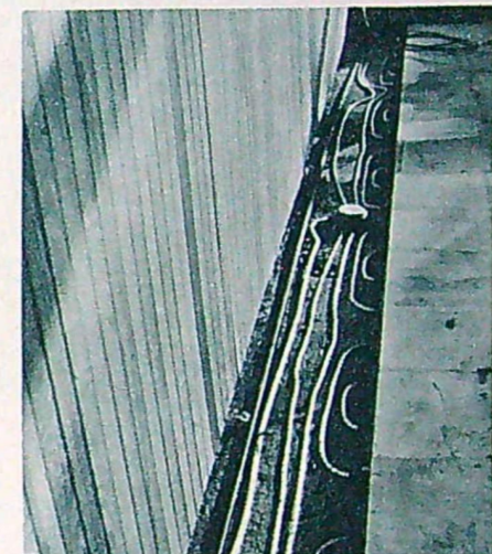
Värmekabeln är med isolering endast 8 mm tjock och består inifrån av den strömförande motståndstråden — motståndet är 0,7 Ohm per meter — en linspinnning, oljat papper, blymantel, tjärpapp och aluminiumband.
