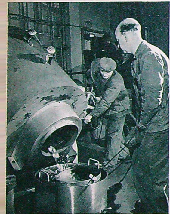
Plums i vattnet åker plattarna när Erik Irborg och Olov Danielsson vänder på oxideringsugnen. Det är en elugn som roterar.
