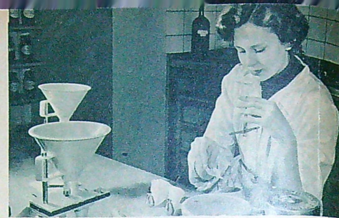
3 Ett preparat har malts och uppvägs för hand av fröken Ingegerd Johansson. Viktsmängder på ca 10 gr och mindre vägs för hand. Vid tillverkning av tusentals liknande preparat används doseringsmaskinen t. v. Den har konstruerats av apotekaren själv, Sten Kjellmark. Tratten överst fylls med pulver och vid varje vridning på en ratt faller en viss bestämd mängd pulver ner i en behållare.
