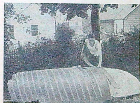
Första steget blir, sedan mallarna byggts, att lägga på det första fanérlagret. Klisterband på alla sömmar hindrar det vattenfasta limmet att lätta ut.
