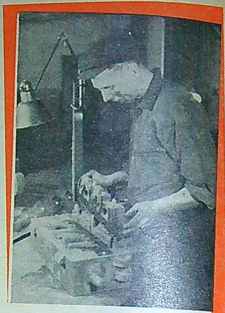
Inläggning av kärnor i formfästa för precisionsgjutning av cylinderblock.
