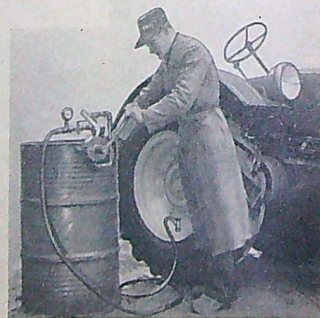
Vatten i stället för luft! Påfyllningen tar 25 minuter per ring med Goodyear-pumpen.
