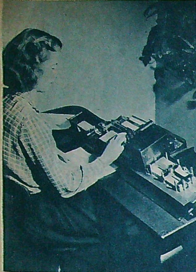
Signalementet på en person överförs till hälskrift på ett hälkort med en stansmaskin. Kapaciteten är 200—500 kort/linne.
