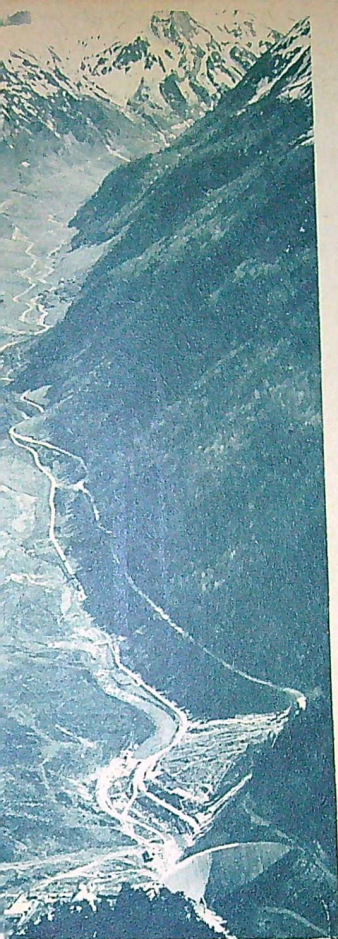
Älven letar sig genom dalgången från den eviga snöns trakter ned till en konstgjord sjö som håller på att byggas i förgrunden.
