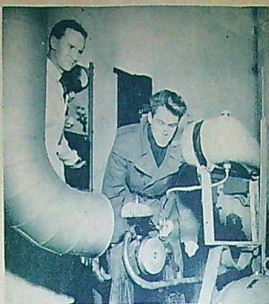
Ingenjör Olof Edlund (t. v.) och Varg-Olle gör belastningsprov på en motor. Denna driver en generator. Effekten och varvtalet kan sedan utläsas direkt på en mitrare.
