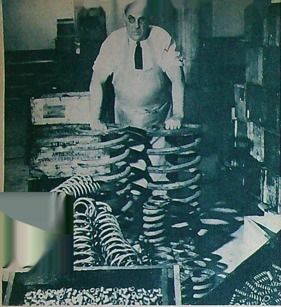
De stora fjädrar som packmastare E. Larsson håller händerna på är avsedda för maskiner. T. v. därom fjädrar för Volvo PV 414, t. h. stötfjädrar för Sjö's boggiwagnar. T. v. i förgrunden ventilfjädrar till bilar, t. h. ventiltjädrar för värmeledningar.
