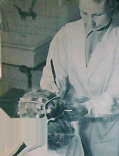
Med ett system av gummislangar trycks metallektrodena över hjärnskålen. Spänningarna från hjärnbarken tas ut med dessa.
