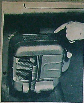
På sommaren kan man stänga av elementet och apparaten tjänstgör då enbart för insläpp av frisk luft.
