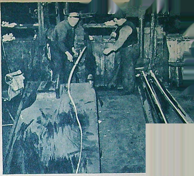
Valvverksarbetarna leker »ornitlusare» och fångar upp de slingrade, vvarmas i rätta bönblicker för att mata in dem i misst vals, där de minntunnare dimension. Ett felgrepp kan betyda livsfarliga skador och pro-
