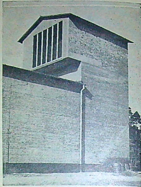
Överbyggnaden på inloppstornet för frisk-luften.
