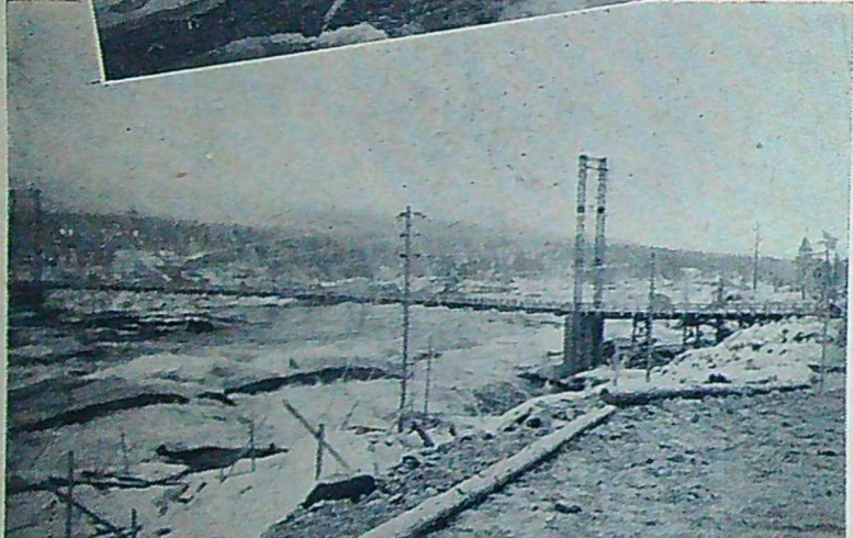
För att underlätta transporterna har man byggt en provisorisk hängbro över älven.
