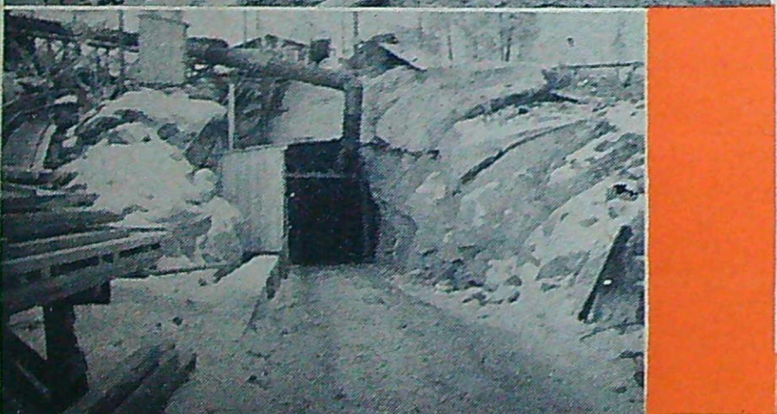
Infarten till omloppstunneln.
