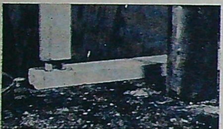
Alla skarvar limmas. 12 mm tappar försänks 20 mm djupt i ramarna.
