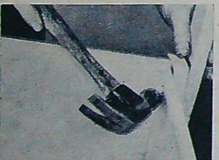
Vanliga möbelstift används att fästa oljeduken vid ramens insida.
