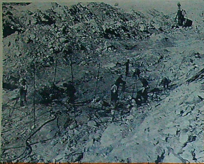
Råämnet för jod, caliche, ligger vanligen på några meters djup, täckt av onyttiga jord- och stenlager. Mäktigheten varierar från några tum till tre à fyra m. Språnghål borras med tryckluft-drivna bergbormaskiner ned till calichen, som friläggs genom på elektrisk väg avtyrade svartkrutladdningar.
